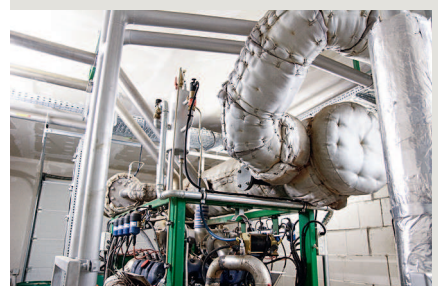
Beim Abgassystem über dem Motor kann Öl nicht in die Isolierung geraten.
