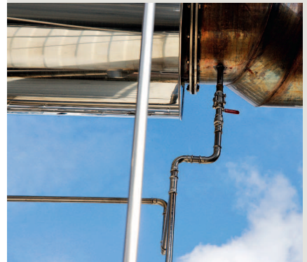
Die nachträglich eingebaute Leitung dient zum Ablauf des Kondensats.
