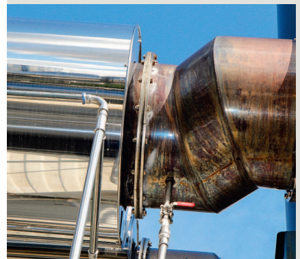
Die großen Rohre sind jetzt durch elastische Dichtung verbunden.
