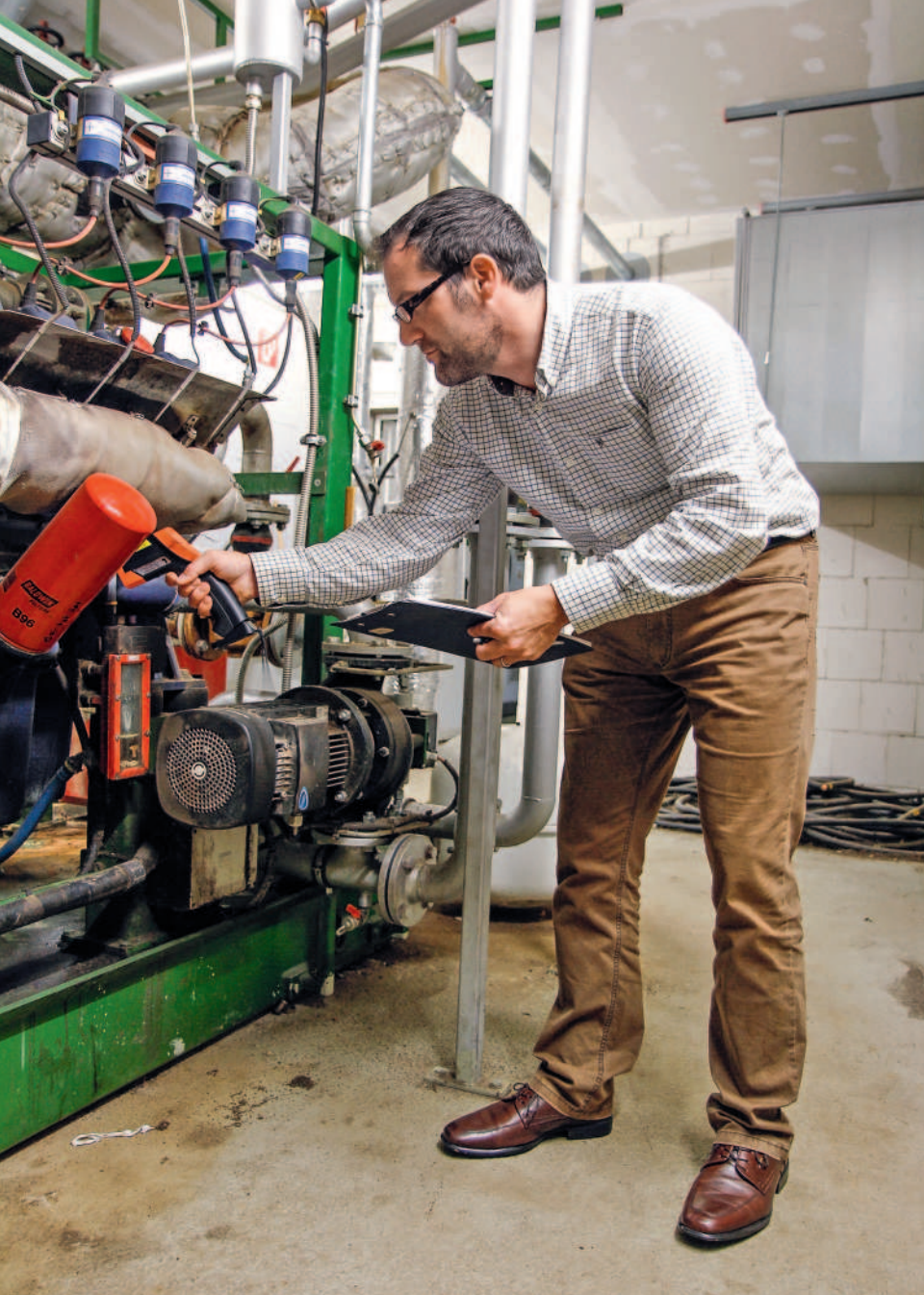
Markus Ermen-Zielonka misst hier die Temperatur am Ölkühler mit einem Infrarotthermometer.
