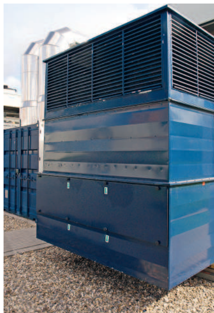
Außenfilter am BHKW-Raum sollten im Frühjahr häufiger gereinigt werden.
